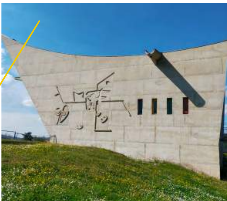
/ MAISON DE LA CULTURE, PIGNON SUD
